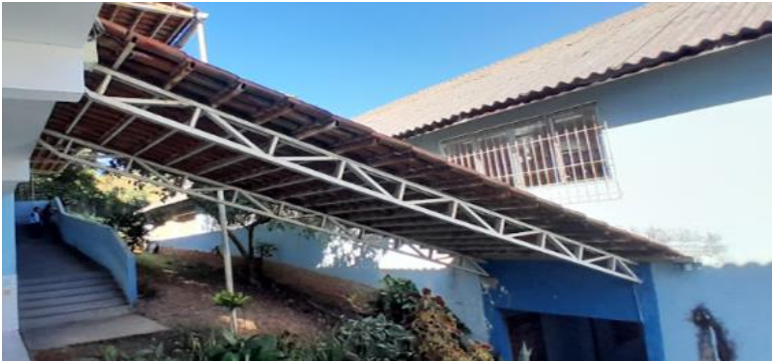
Foto 2: Local das telhas e estrutura metálicas a receberem limpeza.
