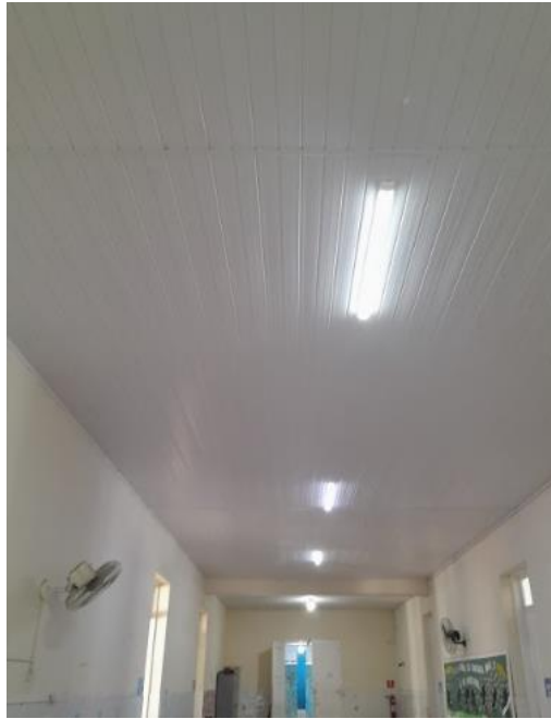
Foto 3: Ex. do local de remoção recolocação do forro de PVC.
