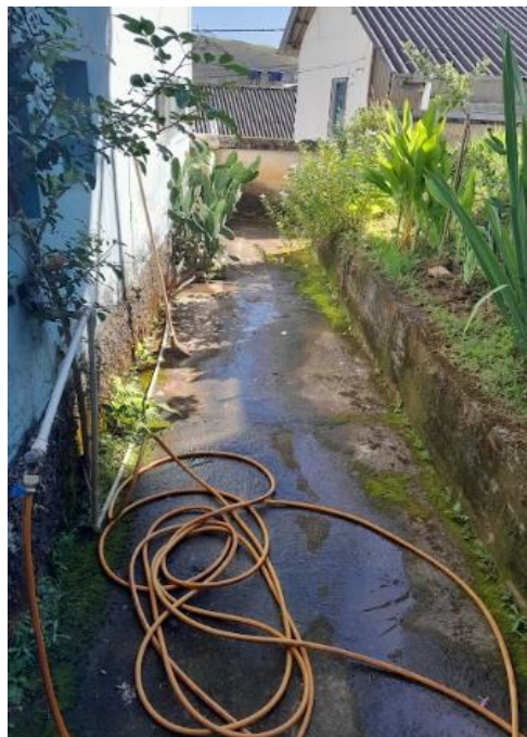
Foto 3: Ex. do local demolição de piso cimentado inclusive lastro de concreto.
