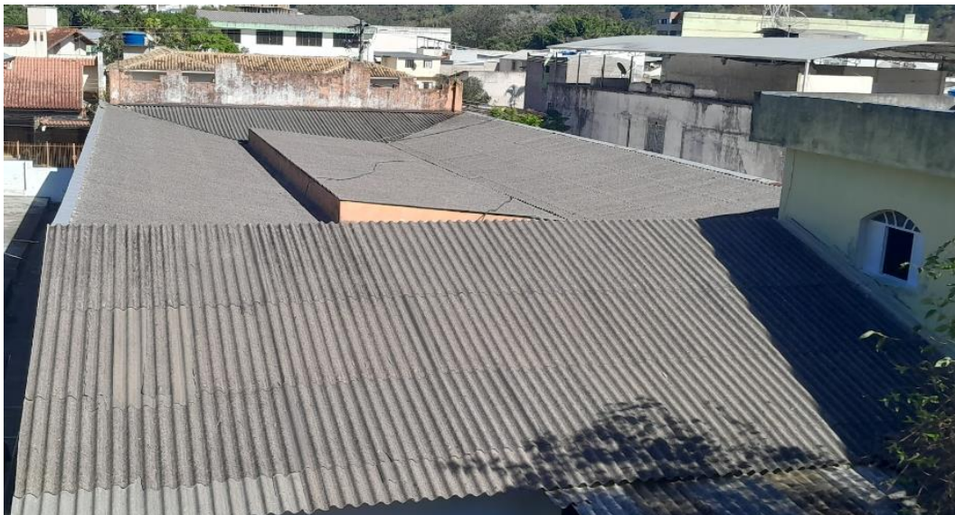
Foto 1: Ex. Um dos locais a serem retiradas as estruturas em madeira e removidas as telhas.
