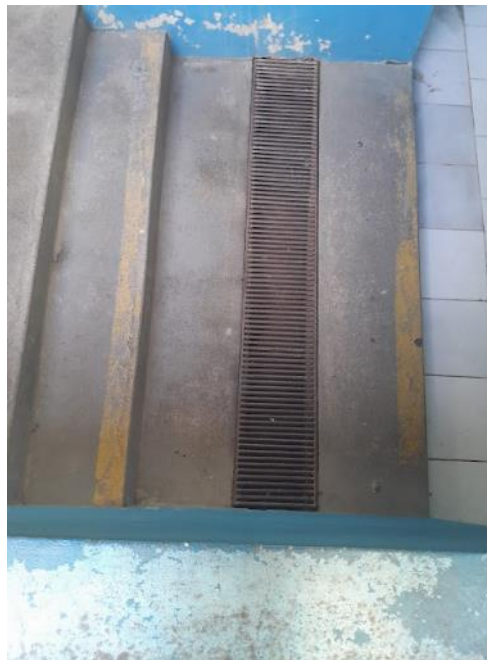
Foto 4: Ex. do local a ser desobstruídos com auxílio de equipamento hidrojato.
