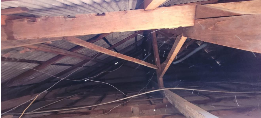
Foto 7: Ex. do local a ser retirada estrutura em madeira do telhado.
