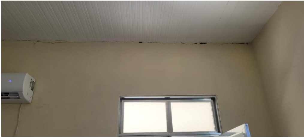
Foto 11: Ex. do local a ser demolido forro de madeira.
