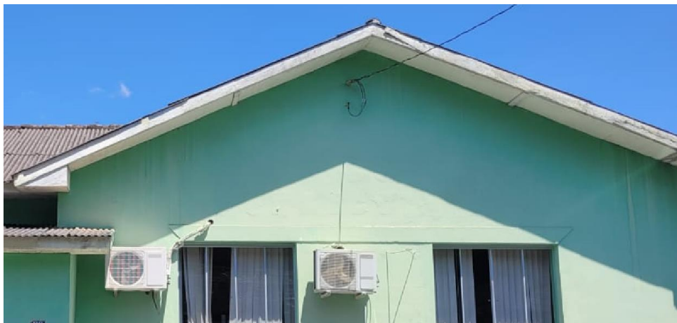
Foto 8: Ex. do local a ser demolida alvenaria.
