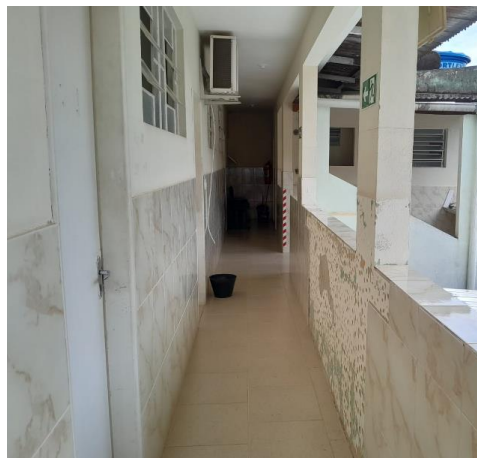
Foto 4: Ex. do local a ser retirada portas e janelas de madeira, inclusive batentes
