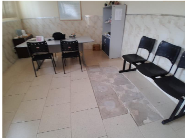
Foto 1: Ex. do local da demolição dos pisos.
