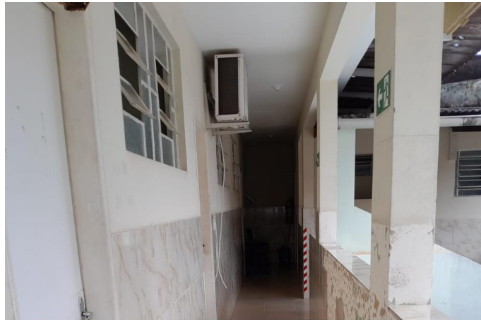
Foto 13: Ex. do local a ser retirada esquadrias metálicas.
