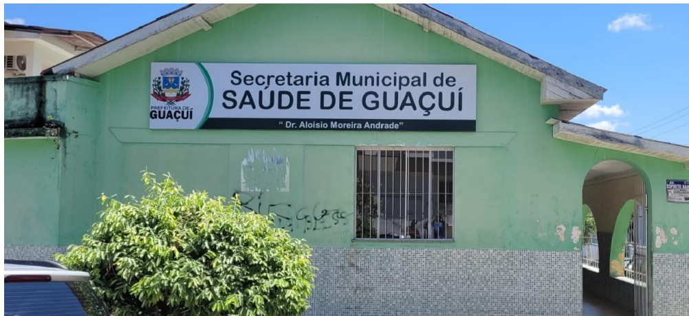
Foto 5: Ex. do local a receber lixamento de parede.
