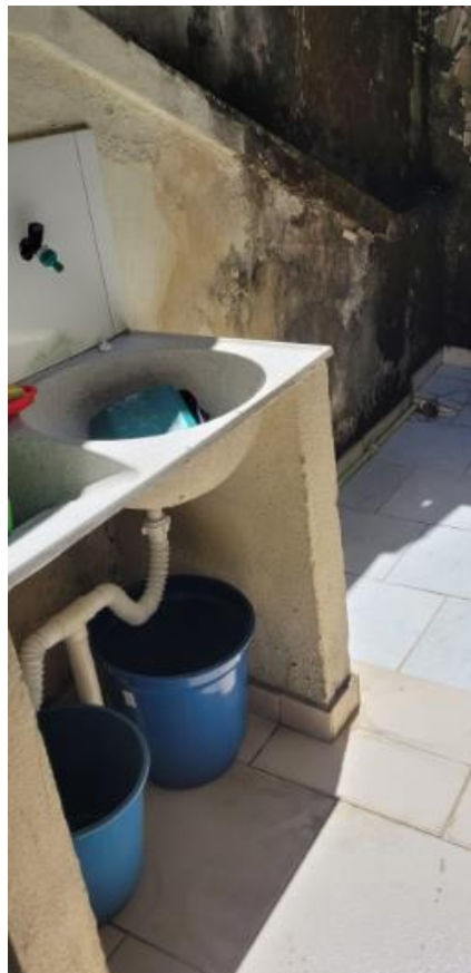
Foto 12: Tanque a ser retirado.
