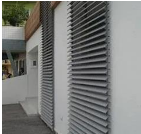
Figura 7: Brise metálico Hunter Douglas ref. 84R-SL4, cor prata.
