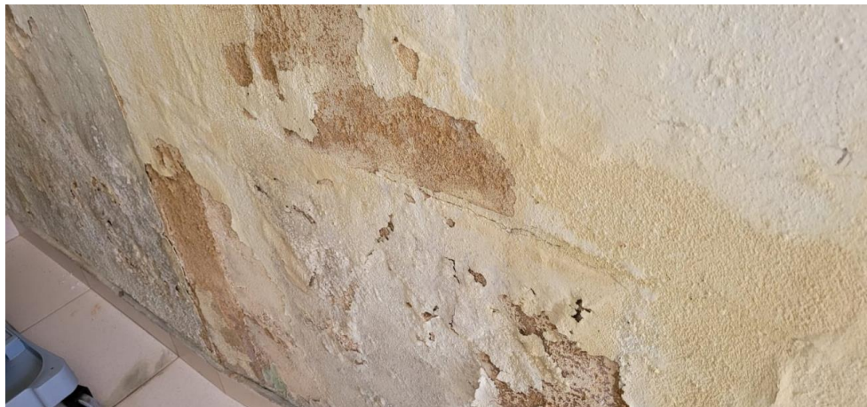
Foto 2: Ex. do local a ser retirado reboco antigo.
