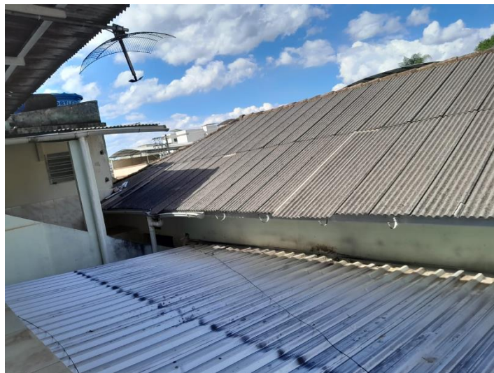
Foto 6: Ex. do local a ser removido as telha ondulada de fibrocimento.
