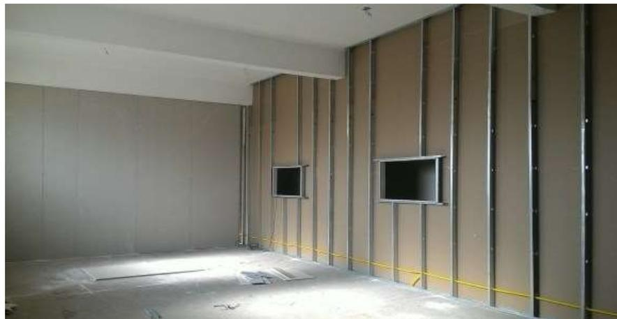
**Figura 1:** Parede de Drywall
