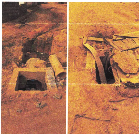
Foto 05 e 06 – Situação atual da Rua Projetada "D"
