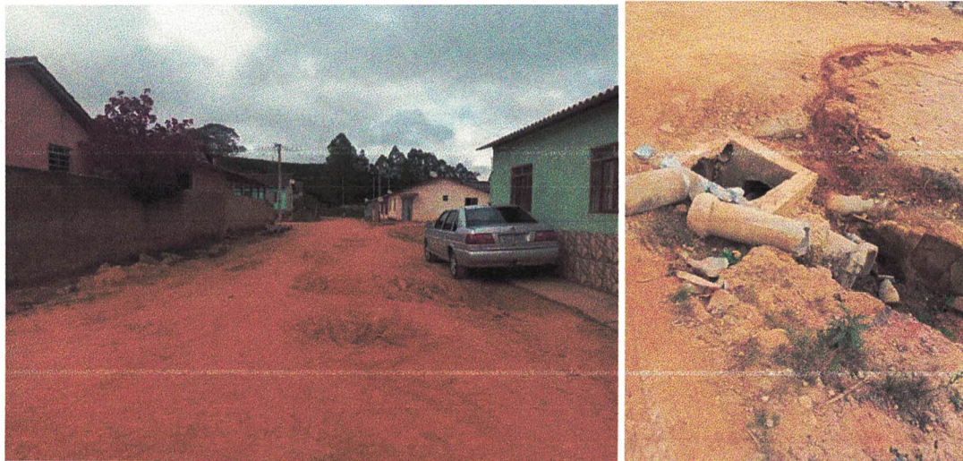
Foto 03 e 04 – Situação atual da Rua Projetada "D"
