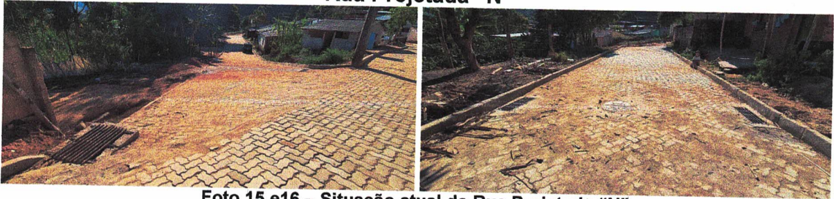
Foto 15 e16 – Situação atual da Rua Projetada "N"
