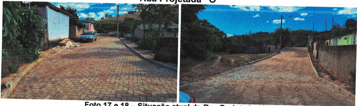
Foto 17 e 18 – Situação atual da Rua Projetada "O"
