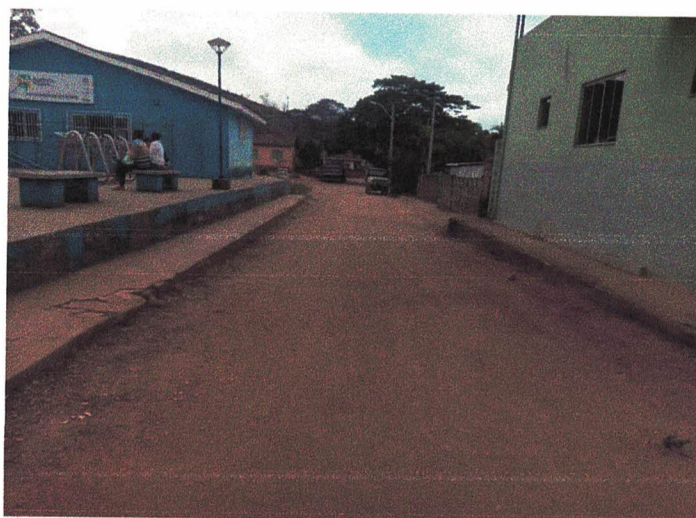
Foto 02 – Situação atual da Rua Projetada "C"
