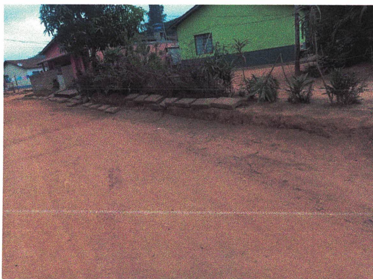
Foto 01 – Situação atual da Rua Projetada "A"
