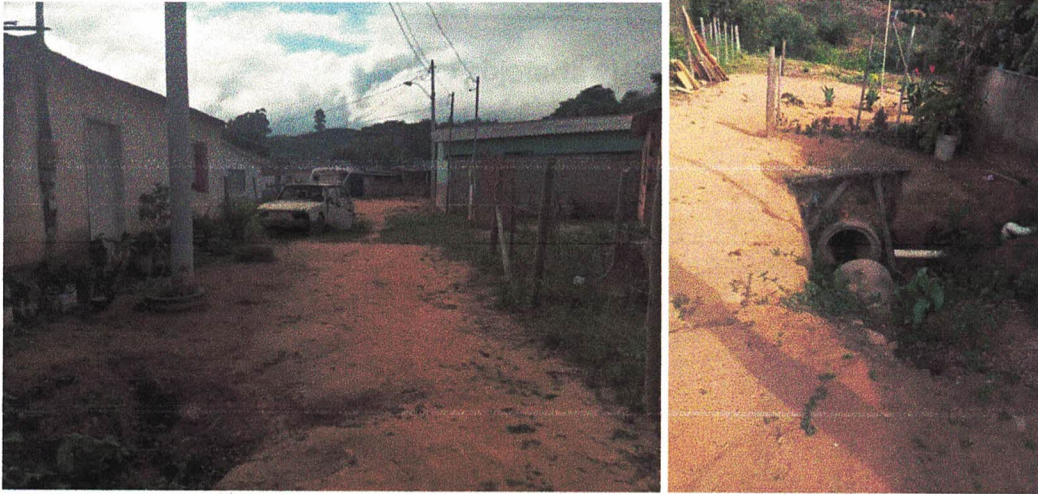
Foto 10 e 11 – Situação atual da Rua Projetada "F"
