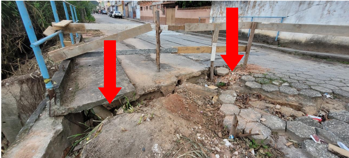
FOTO 3: Execução da viga para travamento ponte e rua.
