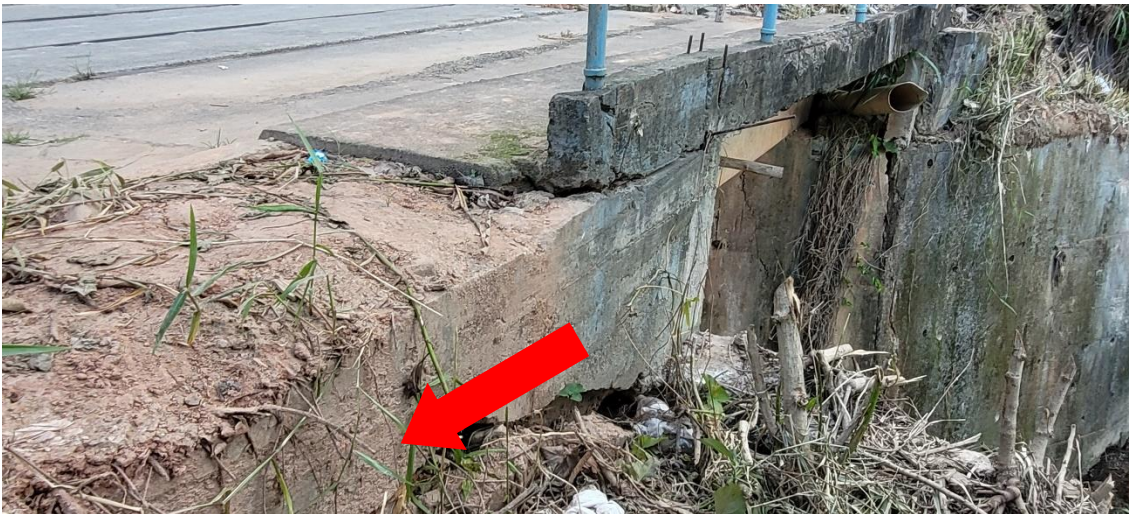
FOTO 2: Execução da viga para conter passeio.
