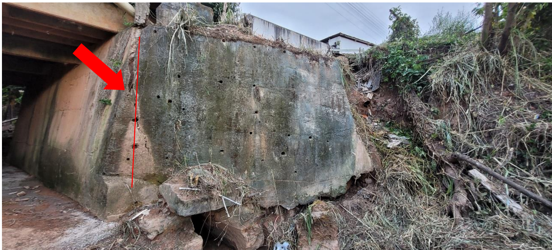
FOTO 1: Indicação da linha de início da demolição do muro.
