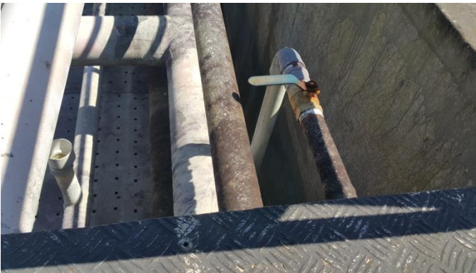
Foto 31 – Troca de tubulação do sistema de aeração para facilitar acesso as válvulas.
