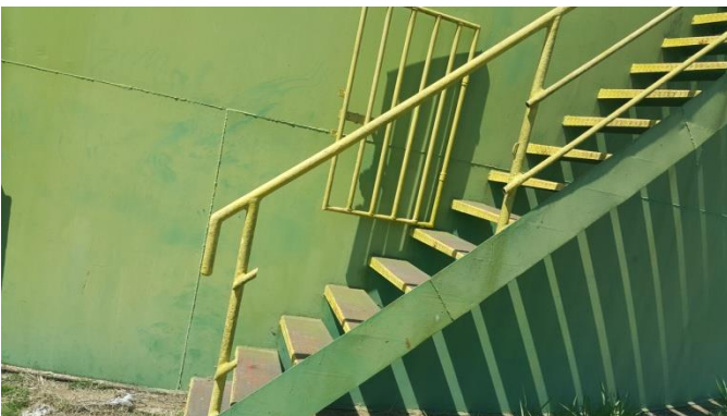
Foto 27 – Recuperação da escada de acesso a parte superior da Estação.
