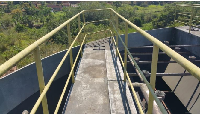
Foto 25 – manutenção/laminação das chapas de aço dos pisos para transito na parte superior da Estação.
