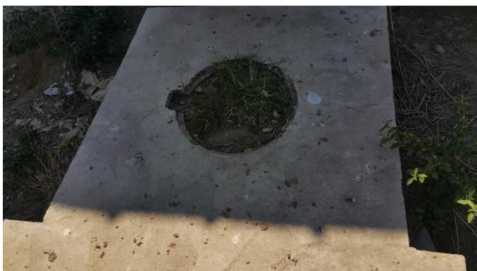
Foto 41 – Instalação de tubulação de chegada e de tampão esgoto em ferro fundido.
