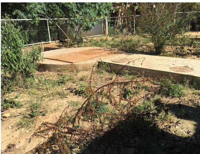
Foto 42 – Regularização do terreno, urbanização e instalações elétricas.
