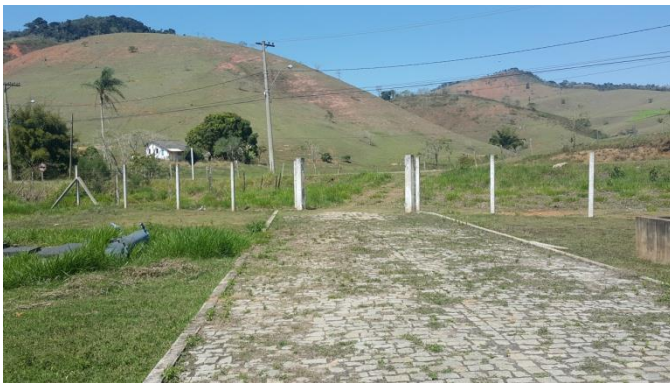
Foto 01 – Falta portão de acesso à Estação.
