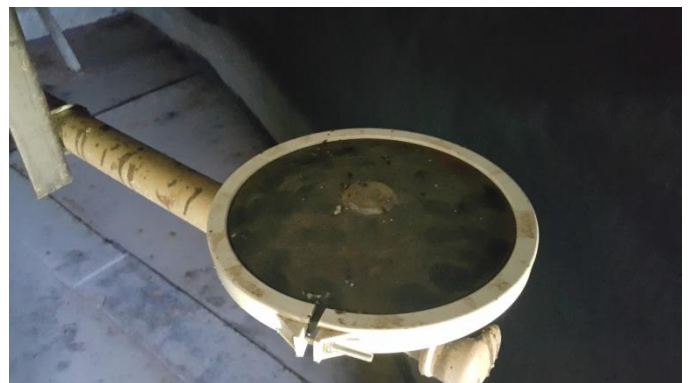
Foto 16 – Troca dos difusores do sistema de distribuição de ar.
