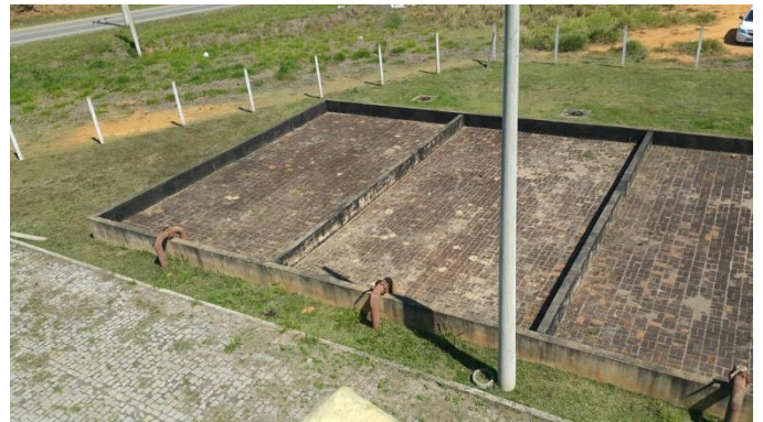
Foto 36 – Limpeza dos leitos de secagem, além de impermeabilização e pintura das paredes.
