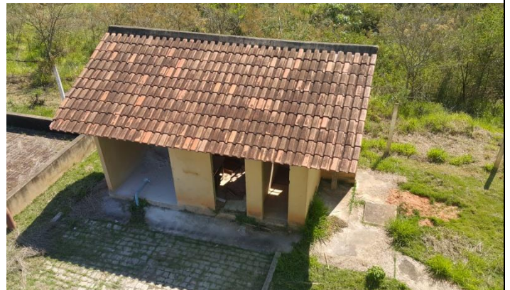
Foto 32 – Foto superior da casa de operação
