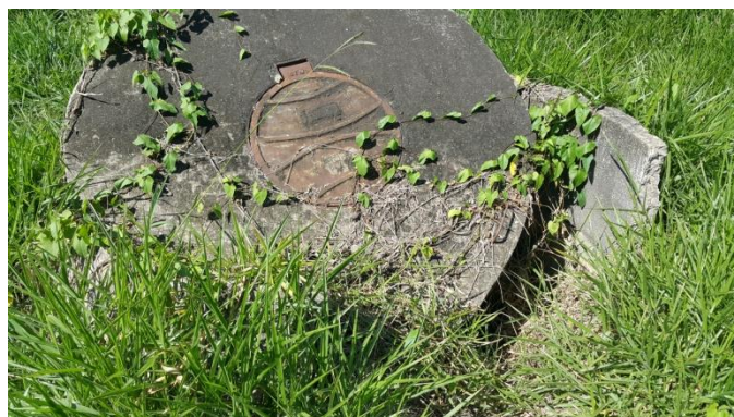
Foto 40 – Troca de anel de concreto.
