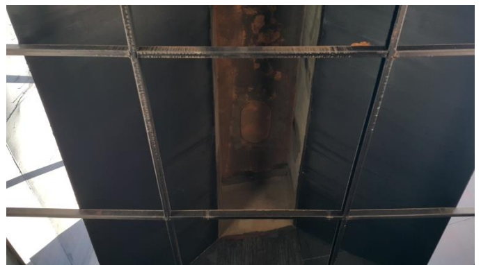
Foto 22 – Necessidade de troca das bocas de visitas da câmara de biogás e suportes, que já estão fletindo com o próprio peso.
